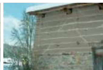
Grange en Pisé à Chaumont Le Bourg
