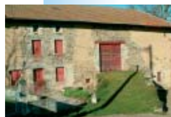
Façade et montée de ferme à Doranges
